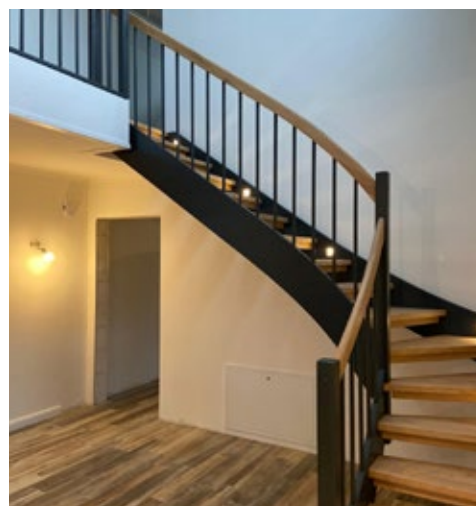
RAL-lackierte Holztreppe mit Stufen und Handlauf aus Eiche sowie LED-Lichtern
